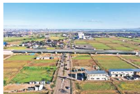
県内には当社が施工した橋梁が多数あります
