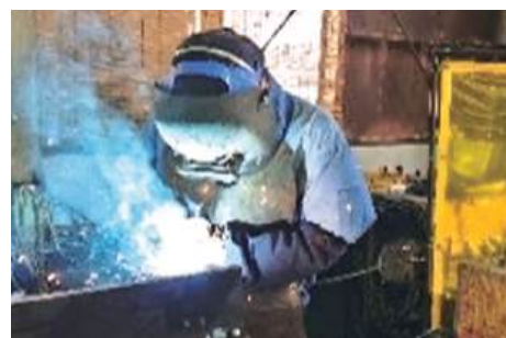
技能の蓄積という職人技で溶接します
