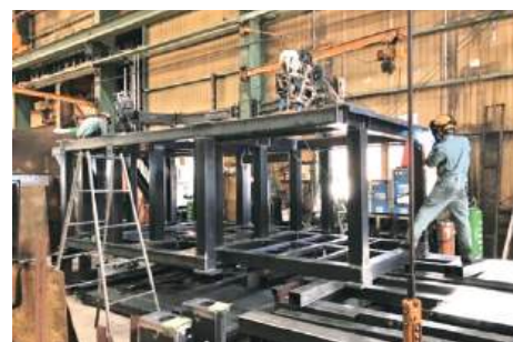
重量物の溶接
