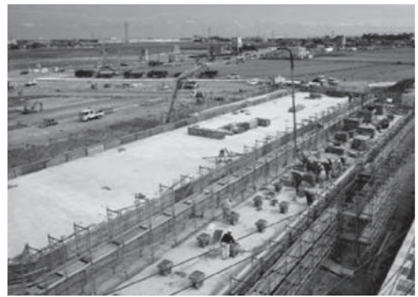
屋根部分のコンクリート打設の様子
