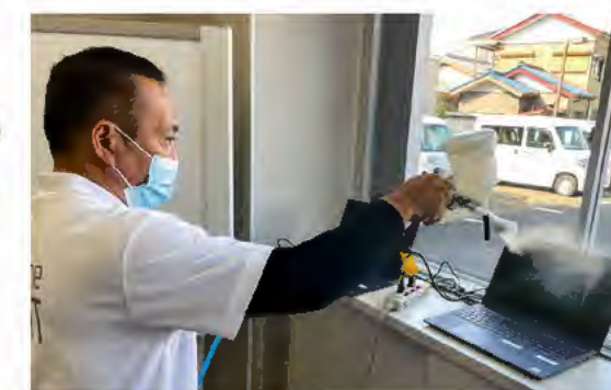
「ナノゾーンコート」施工の様子
